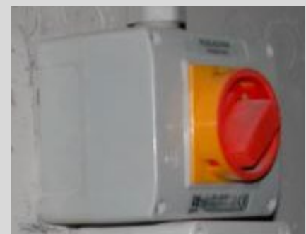
Rys.3 Przykładowy wyłącznik 3 fazowy z blokadą położenia
